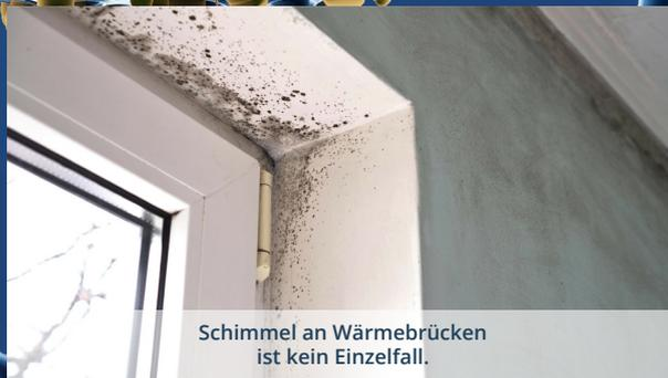
Schimmel an Wärmebrücken ist kein Einzelfall.
